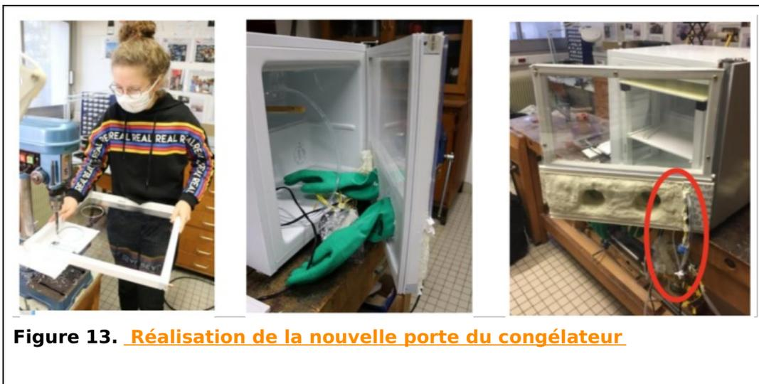
**Figure 13. Réalisation de la nouvelle porte du congélateur**
