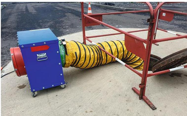
↑ PHOTO 4 Exemple de passage d'une gaine dans un tampon. Le ventilateur (bloc bleu) reste à l'extérieur de l'ouvrage, prélève l'air extérieur (partie en rouge) et l'insuffle dans l'ouvrage via la gaine (jaune). À noter le tampon métallique en position ouvert, permettant le passage de la gaine dans le regard, et la mise en place d'une protection collective contre les chutes, sous la forme d'une barrière rigide.
